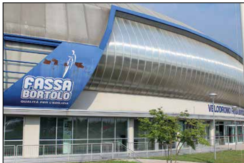
Il problema della manutenzione del Velodromo Fassa Bortolo. (Foto Mor)
